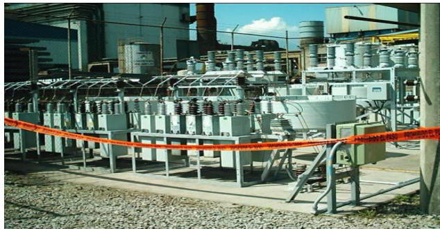
Filtro de absorción de corrientes armónicas para compensar un horno de arco. (diseñado por el Dr. Ing. Alfredo Navarro Crespo).
