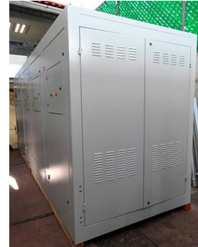
Banco de capacitores en media tensión. Proyecto KIA Monterrey (diseñado por el Dr. Ing. Alfredo Navarro Crespo).
